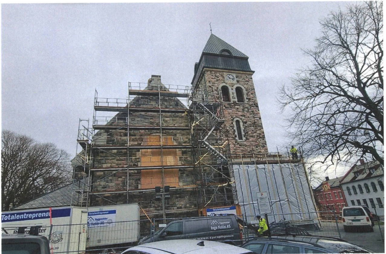
Det arbeides på Ålesund kirke, rehabilitering av tak og fasade.
